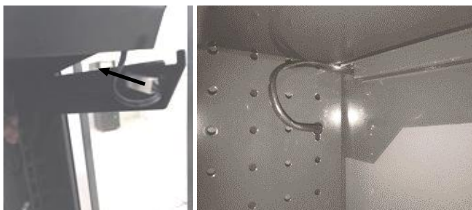
Abb. 9: Kabel LED-Balken verlegen
